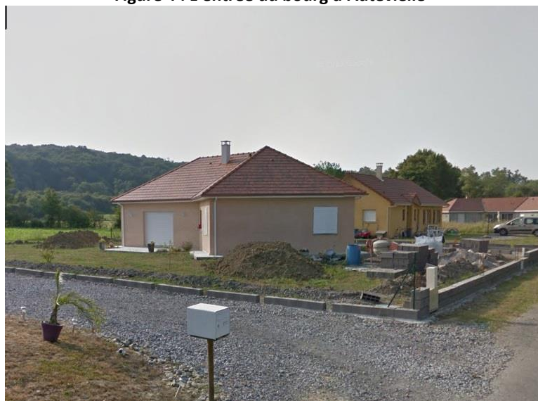
Figure 5 : Le lotissement de Saint-Martin
